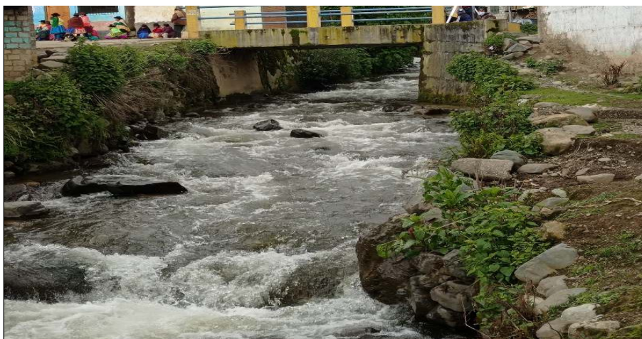
FIGURA N°07: EN CIERTOS TRAMOS DEL MARGEN DERECHO DEL RIO QUIO MAYO SE APRECIA QUE LA POBLACIÓN HA CONSTRUÍDO MUROS DE PIEDRA SIMPLEMENTE COLOCADOS.
